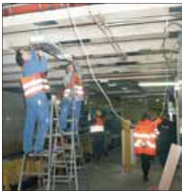
Eine weitere Leuchte am Bahnsteig B wird montiert.
