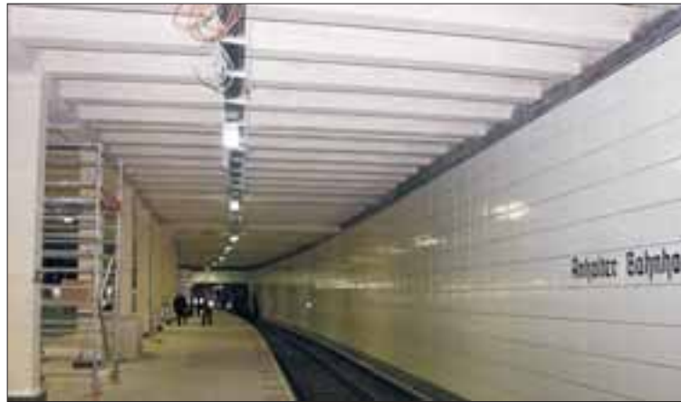
Für den provisorischen Betrieb fast fertig: Bahnsteig B, an dem ab 23. Dezember, etwa 4 Uhr, die Züge Richtung Norden halten.
