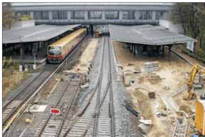
Nadelöhr Westkreuz: Das nördliche Gleispaar und der Bahnsteig sind derzeit wegen der Bauarbeiten außer Betrieb. Zusätzlich kreuzen sich die beiden verbliebenen Gleise kurz hinter dem Bahnhof, so dass derzeit statt 4 Zügen immer nur einer fahren kann.
