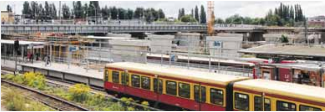
Unübersehbar sind die Stützen für den Ringbahnbrückenzug der S-Bahn
