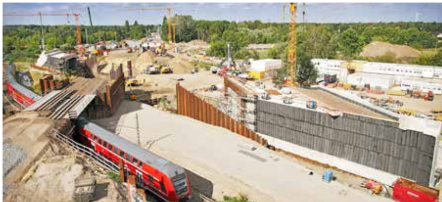
Rege Bautätigkeit am Karower Kreuz. Ein Regionalzug ist noch auf der Umfahringkurve unterwegs. Diese wurde für die Zeit der Bauarbeiten eingerichtet.
