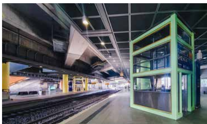
Foto: Baumeister/Deutsche Bahn AG
