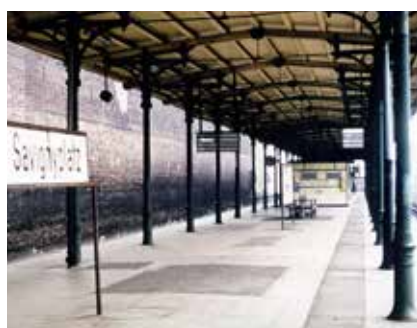
Der Bahnhof erhielt ein Dach nach dem Muster der Wannseebahn-Stationen.
