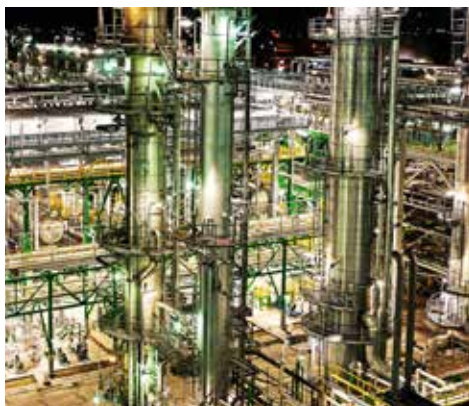
Nachtaufnahme: Die PCK-Raffinerie ist ein Erdölverarbeitungswerk in Schwedt/Oder.
