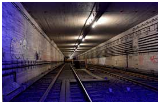
Der „Heuboden“ ist eine Kehranlage am Potsdamer Platz für die S-Bahnen.
