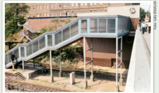
Weil der Senat die Brücke verbreitert hat, zahlte er für die Reichsbahn den Neubau von Empfangsgebäude und Bahnsteigzugang. Die Freude währte nicht lange, denn zum Aufnahmezeitpunkt 1981 fuhren seit dem Reichsbahnerstreik (September 1980) keine S-Bahnzüge mehr auf dem westlichen Teil des Rings.
