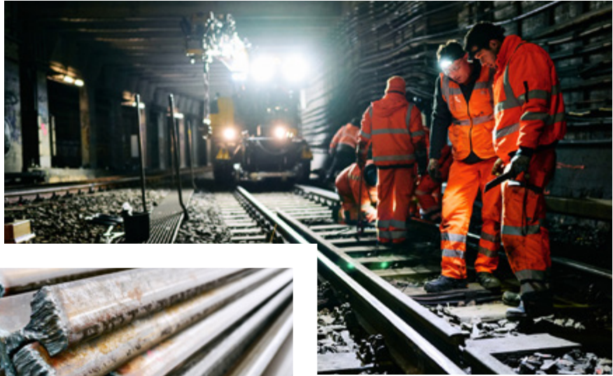
Aufwendige Arbeit auf engem Raum: Die alten abgefahrenen Gleise werden gegen neue ausgetauscht.
