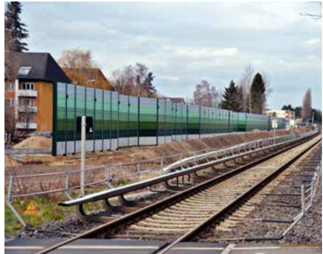
Fast fertig bevor die Bauarbeiten an der „Dresdner Bahn“ richtig begonnen haben: In Lichtenrade ist die Lärmschutzwand bereits 350 Meter lang.
