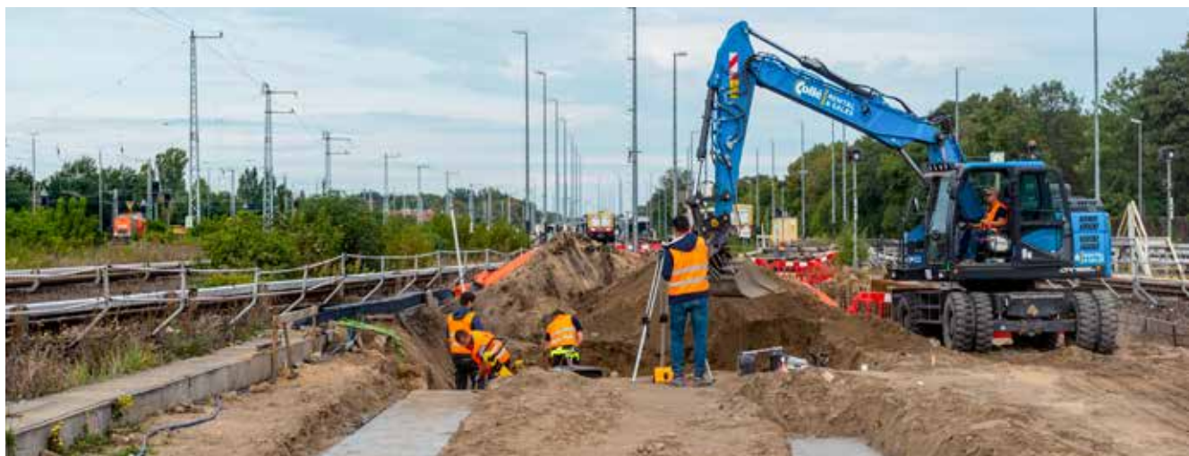
Die Arbeiten für die neue Waschanlage sind in vollem Gange.
