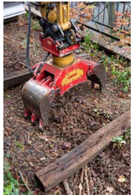
Per Bagger werden täglich rund 60 Schwellen vom Viadukt gehoben und abtransportiert.
