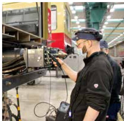
Stefan Boldt bei der Isolationsprüfung
