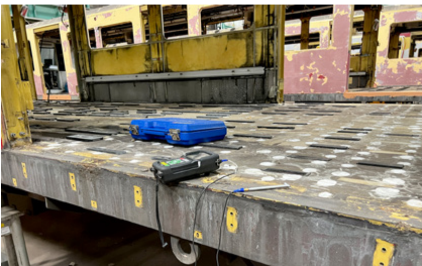
Die Züge werden im Rahmen des Projekts Langlebigkeit komplett auseinandergebaut und im Werk Schöneweide saniert.
